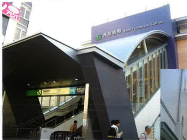
JR西船橋駅エスカレーターコスモプラン新設工事
