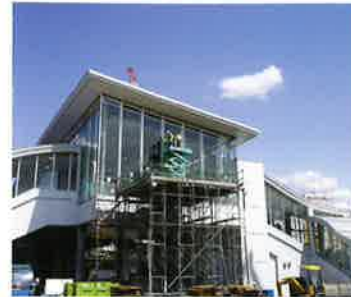
JR篠ノ井線松本駅西口新築工事
