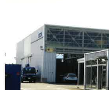
金属鋼板への施工
